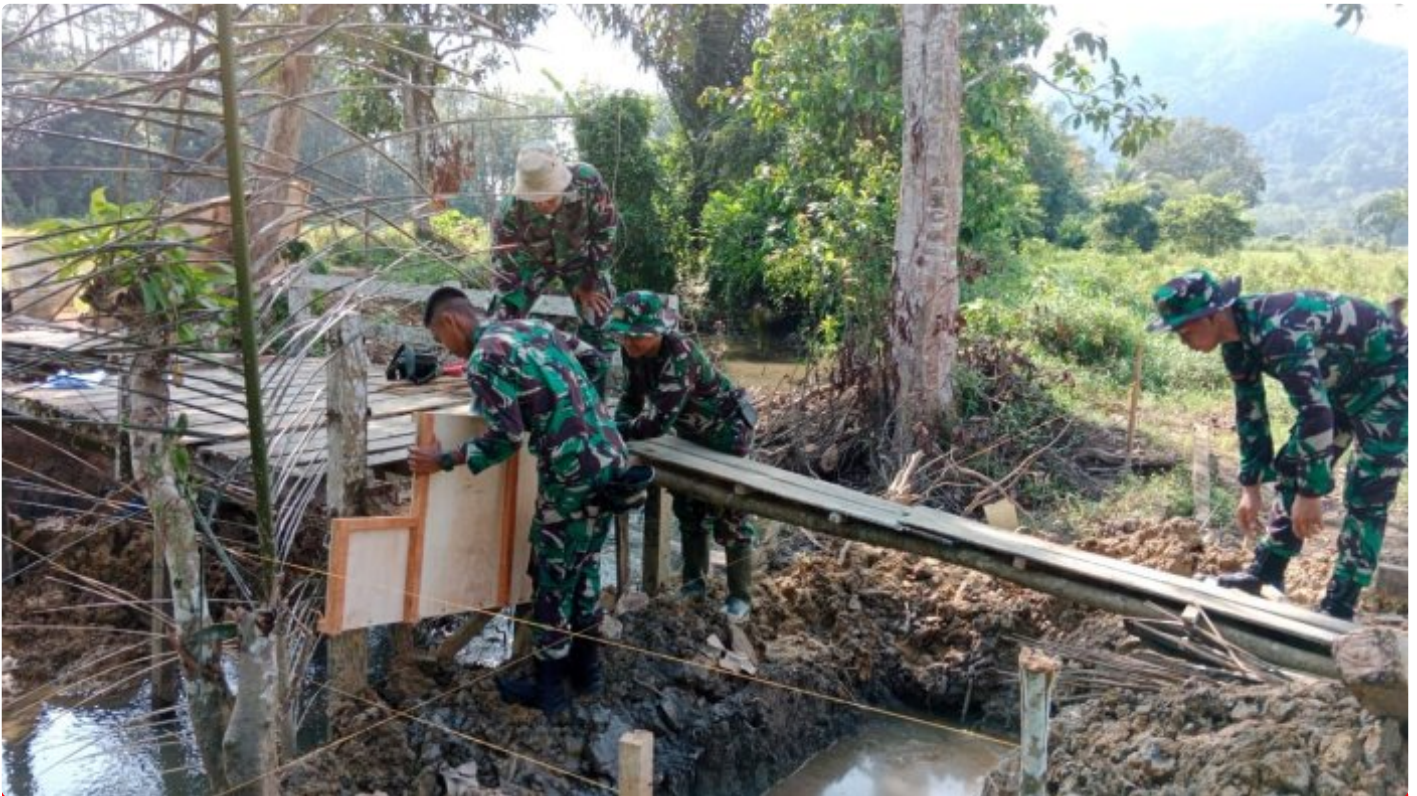
Satgas TMMD ke-116 Kodim 1002/HST Dikerjakan Jembatan
