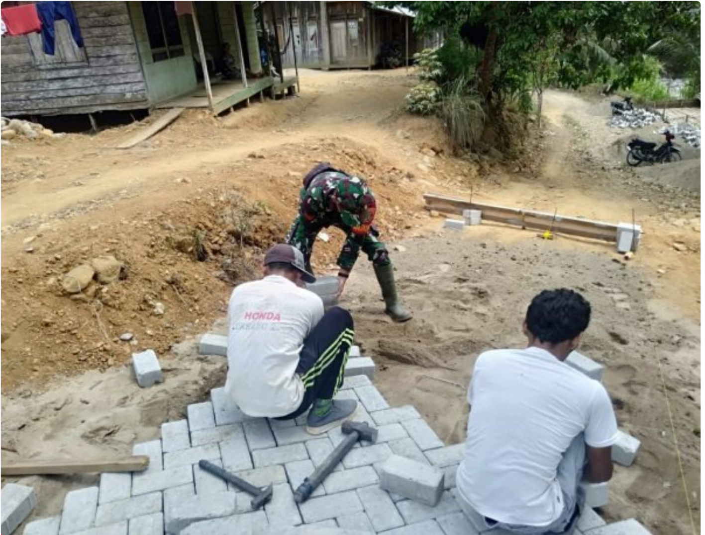
Koptu Erli Bersama Warga Gotong-royong Bangun Jalan Di Desa Hinas Kiri
